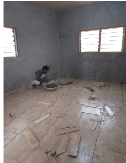
Lisärakennuksen yläkerran lattiatyöt edistyvät.
